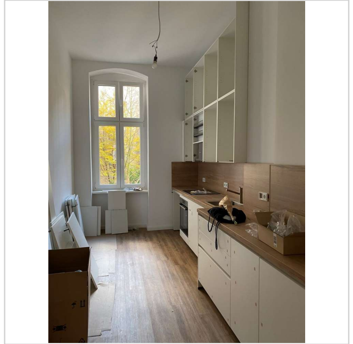
Küche im Aufbau
